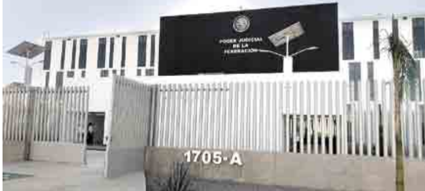
Observaciones. El edificio de la Ciudad Judicial en Torreón resultó con observaciones para el Poder Judicial de la Federación.
