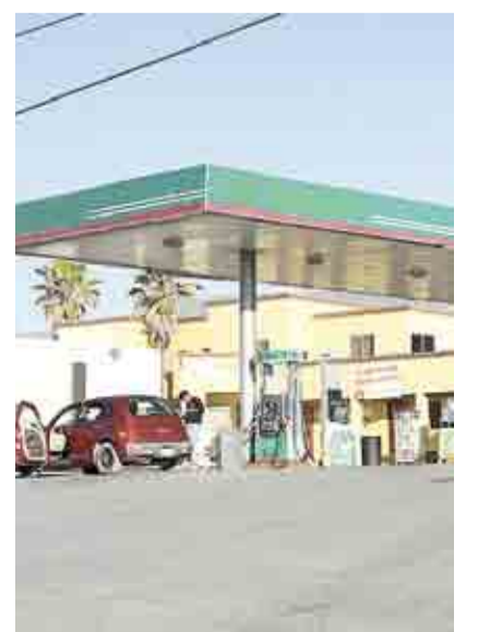
Opera. La estación ubicada en bulevar Fundadores sigue funcionando.
